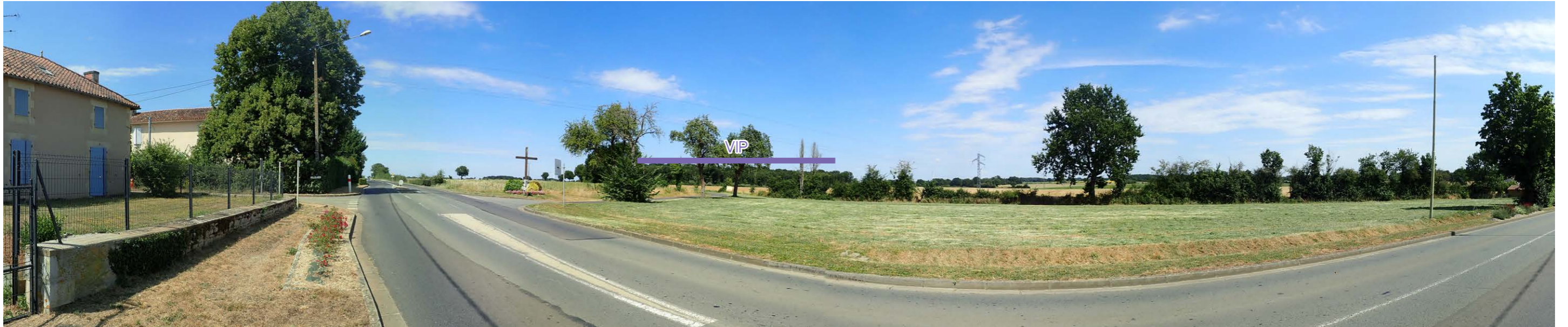
Photo 45 : Depuis la sortie en direction du VIP à La Ferrière-Airoux, le VIP est filtré par la végétation
