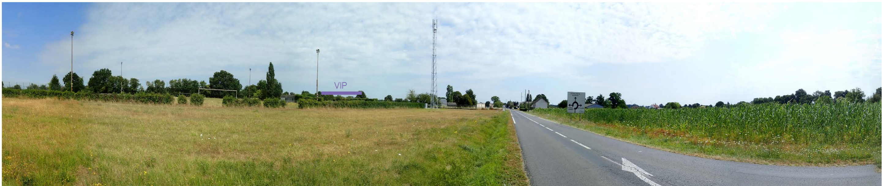
Photo 40 : Une situation de concurrence visuelle est observée depuis la RD 727 entre Jousse et le VIP
